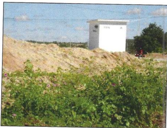
Figura 10. Visão da casa de força do campus. Fonte: Trabalho de campo, realizado em julho/2009. Arquivo Pessoal do autor.
