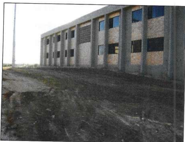
Figura 9. Vista do local após a limpeza dos entulhos e terraplanagem Fonte: Trabalho de campo, realizado em julho/2009. Arquivo Pessoal do autor.
