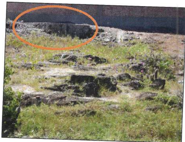
Figura 18 – Tanque de alvenaria (destaque). Fonte: Trabalho de campo, realizado em Julho/2009. Arquivo Pessoal do autor.
