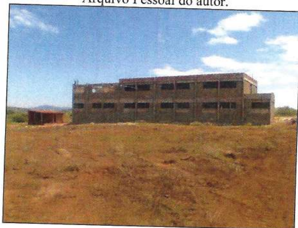
Figura 5. Local com a terraplanagem efetuada. Fonte: Trabalho de campo, realizado janeiro/2009. Arquivo Pessoal do autor.
