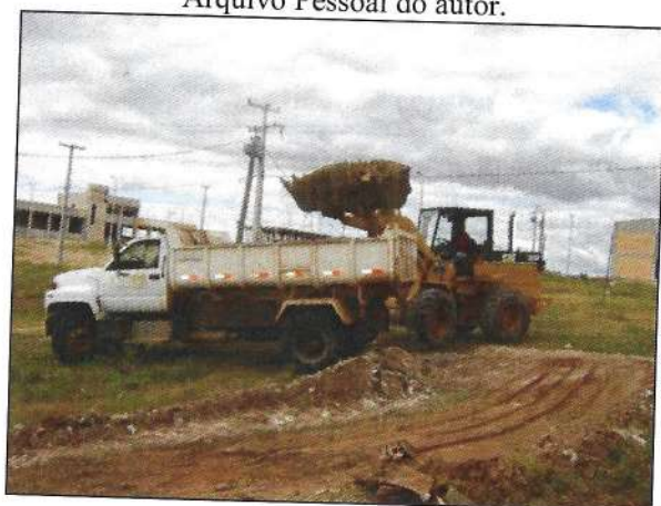
Figura 7. Pá-Enchedeira e Caçamba recolhendo entulhos Fonte: Trabalho de campo, realizado em julho/2009. Arquivo Pessoal do autor.
