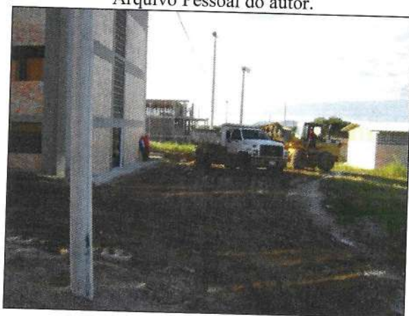
Figura 8. Pá-Enchedeira e Caçamba recolhendo entulhos Fonte: Trabalho de campo, realizado em julho/2009. Arquivo Pessoal do autor.
