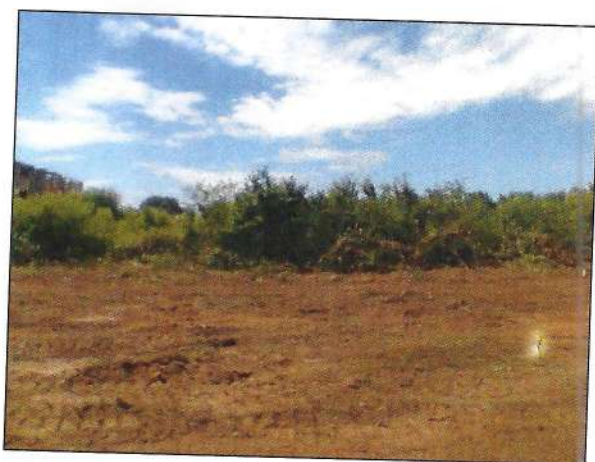
Figura 6. Local com a terraplanagem efetuada. Fonte: Trabalho de campo, realizado em janeiro/2009. Arquivo Pessoal do autor.
