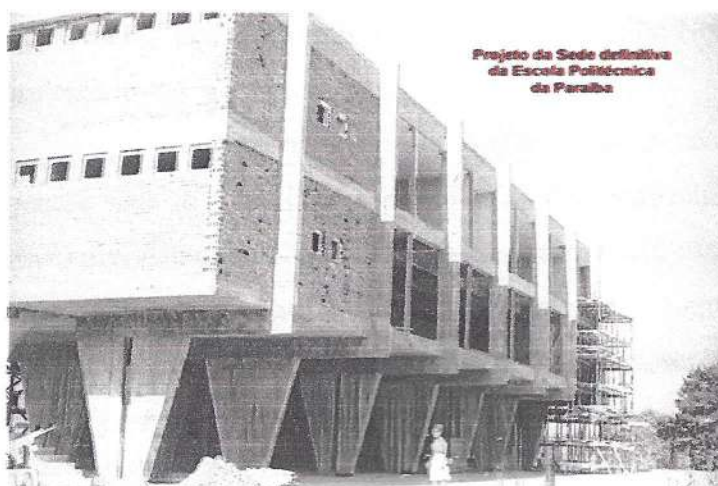
Foto 2: Prédio da Escola Politécnica da Paraíba em construção, onde, na atualidade, fica localizado o Centro de Humanidades da UFCG.
