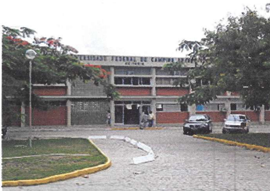
Foto 1: fachada do prédio da Reitoria da UFCG, no campus de campina Grande
