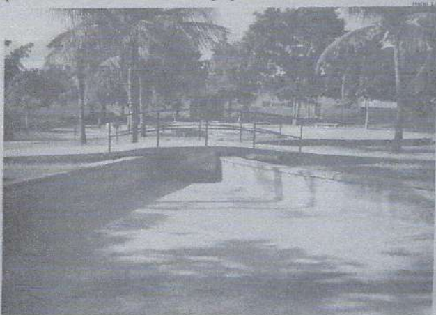
SITUAÇÃO de descuido encontra-se o Parque, nessa imagem vemos o que resta do lago dos peixes, hoje sem água. THONNY HILL
