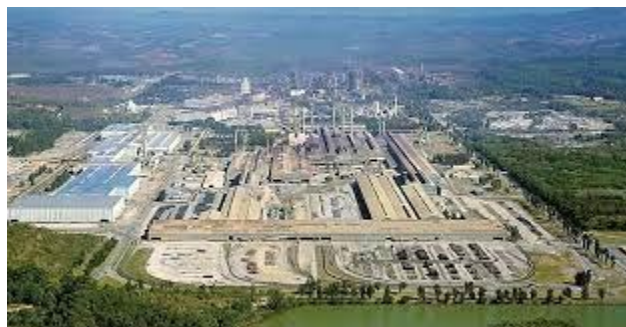
Figura 5 – Fábrica Gerdau em Minas Gerais
